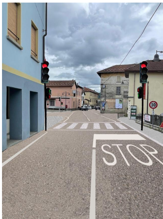
Vista dell'intervento da Via per Alzo
