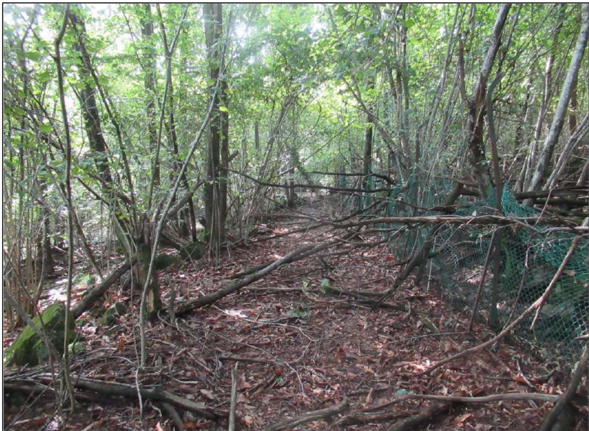
Tracciolino sul confine Oveste da ripristinare
